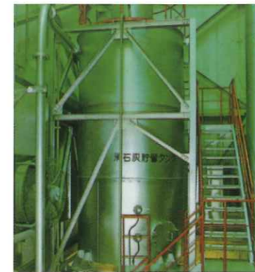
● 有害ガス除去装置 排ガスに含まれている塩化水素を消石灰の噴射によって、効率よく反応させて除去します。
