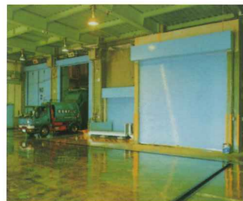
● プラットホーム 計量されたごみは、プラットフォームのごみ投入扉からごみピットに投入されます。
