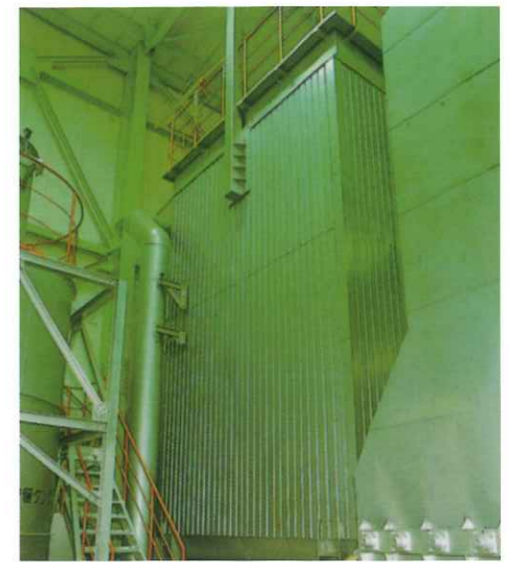
● バグフィルタ 燃焼ガス中の微細なばいじんを取り除いて、きれいなガスにします。
